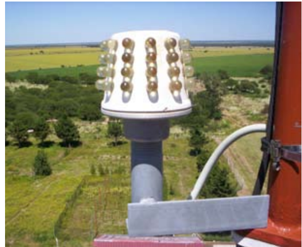
Figura 11: sistema de balizamiento de mástil. / Figure 11: Mast beacon system.
