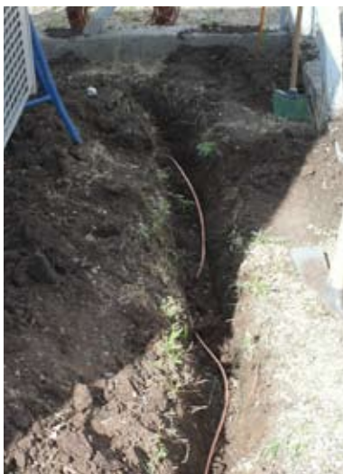
Figura 16: imágenes de la PAT de un shelter. / Figure 16: Shelter GC images.
