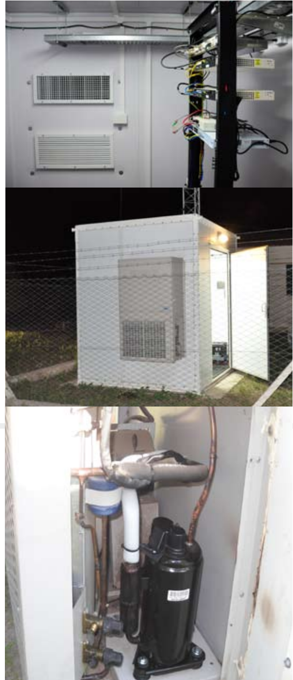
Figura 9: sistema de aire acondicionado de precisión. / Figure 9: Precision air conditioning system.
