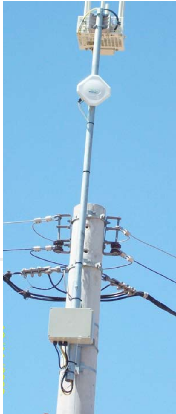
Figura 34: instalación de tecnología Wi-Max como Backhaul de Wi-Fi. / Figure 34: Installation of WiMax Technology as WiFi backhaul.
