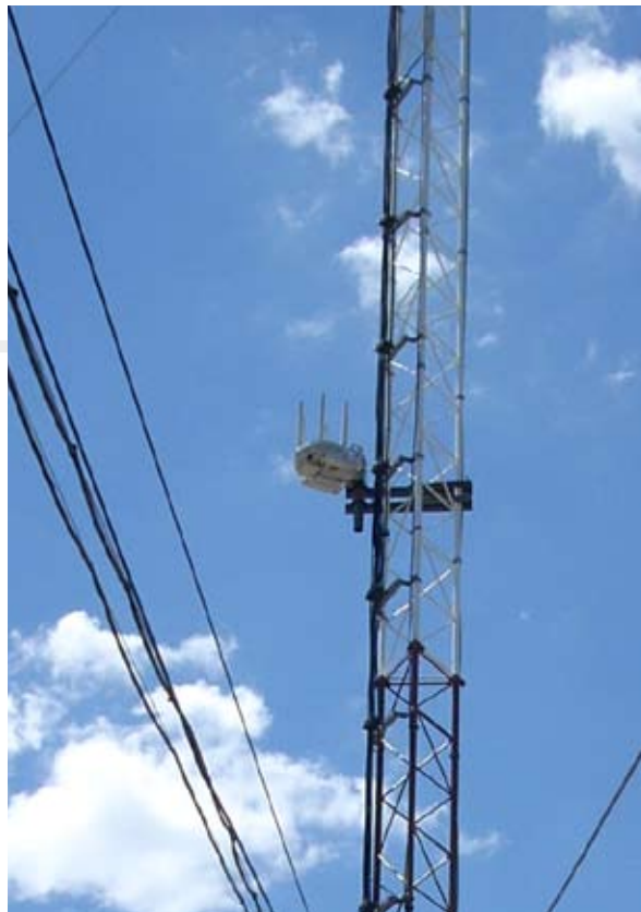
Figura 30: instalación de estación base en poste y en mástil. / Figure 30: Installation of RBS in pole and mast.
