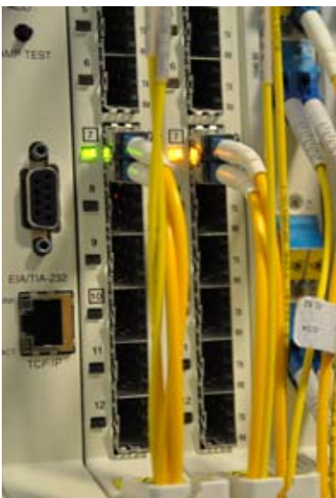
Figura 19: equipo DWDM de la AUI. / Figure 19: AUI DWDM equipment.
