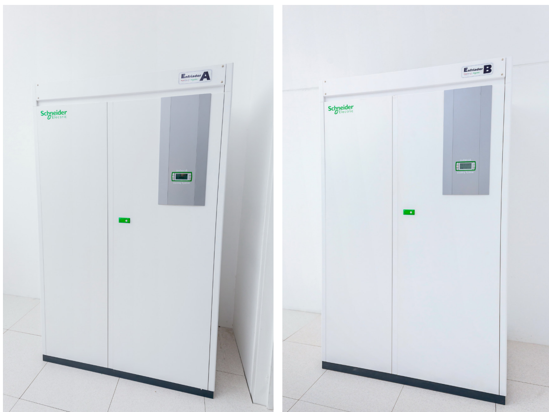
Figura Nro. 28 Sistema de Enfriamiento de precisión
